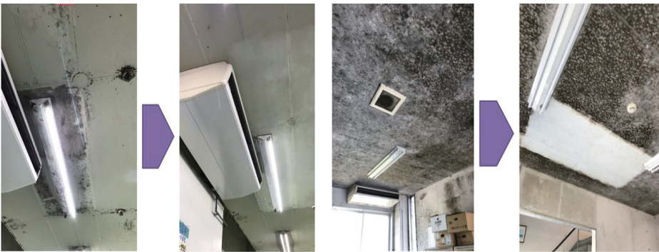
練乳製品工場の施工例
